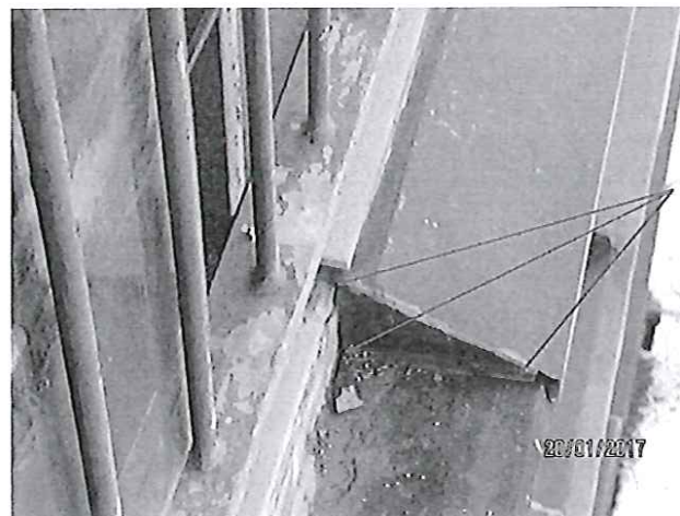
Detail nové okapnice – možnosti zatékání vody
