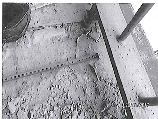
Sonda – těsnící páska na přechodu mazanina - okapnice
