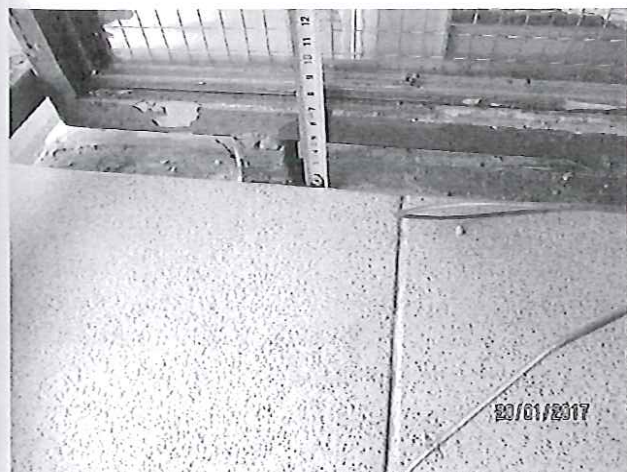
Rozdílná výška dlažby lodžie opravené a neopravené
