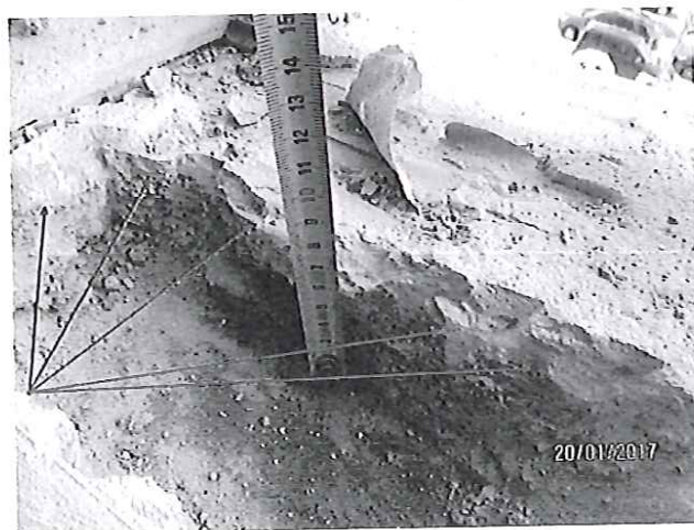
Sonda – zřetelný přechod mezi původní a novou mazaninou
