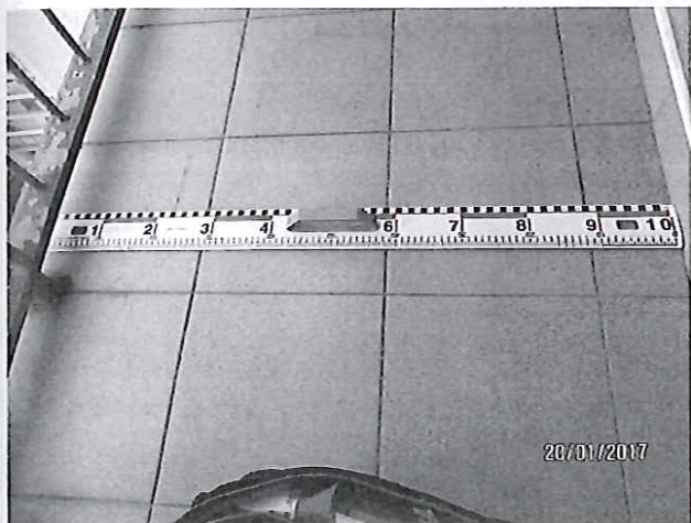
Šířka lodžie, dlažba
