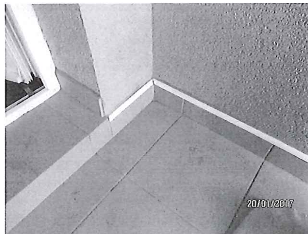
Detail provedení po opravě
